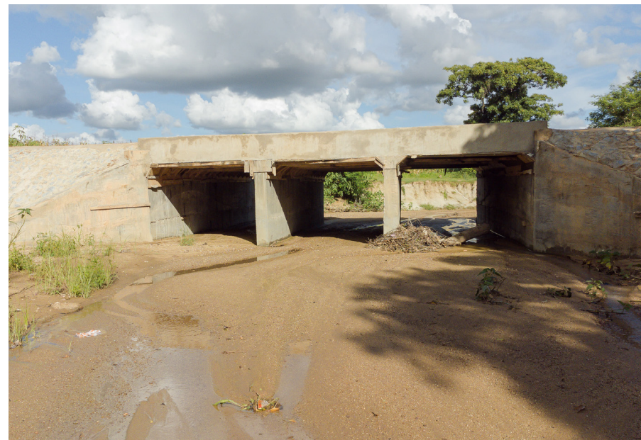
Construction d'un dalot et d'une route en gravier
